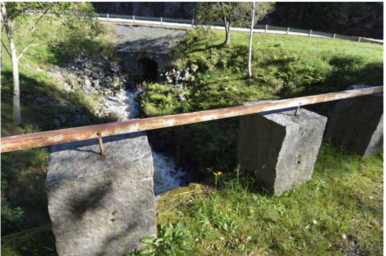
Rekkverk av stabbestein og metall
