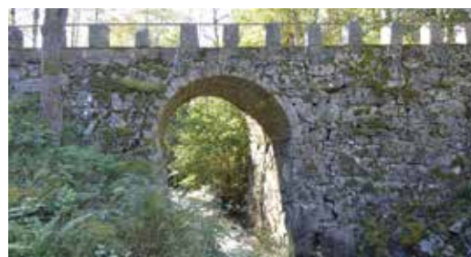
Glenne bru Askeladden-ID 129039-2 NB! Ikke omfattet av fredningen.
