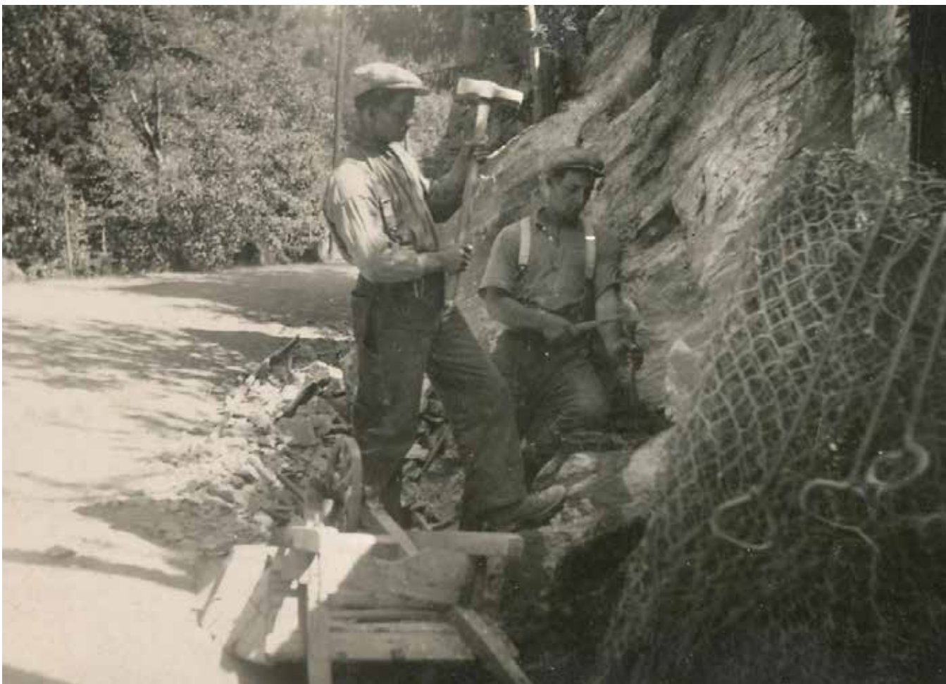
Under: Helge og Harry Johansen fra Ende mens de jobber med utbedring av vegen. Faren var veivokter og var bosatt på Ende. Bildet er ikke datert. Foto: Idd og Enningdalen historielags bildesamling.
