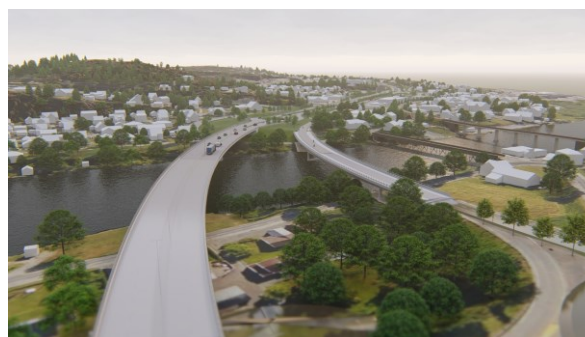
Figur 7-1: Rolvsøysund bru sett fra nordvest
