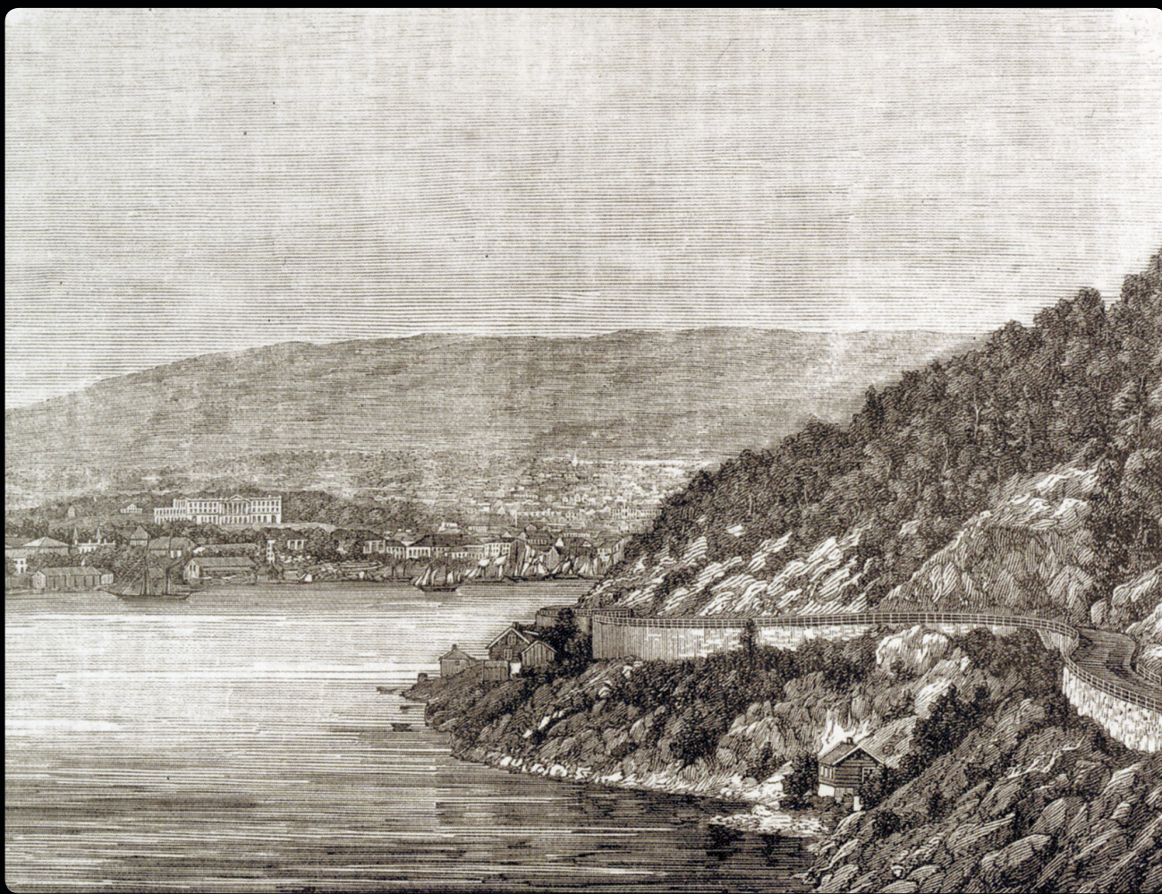
Ljabruchausseen, som går fra Grønland ut langs Bunnefjorden (Mosseveien), representerer et viktig skille i norsk vegbygging. C.W. Bergh fikk gjennomslag for et stigningsforhold på 1:20 og at veien skulle være makadamisert. Foto: Skillingsmagasinet / Norsk Teknisk Museum
