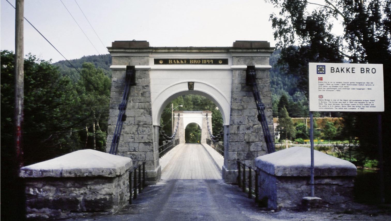
Bakke bro over Sira i Vest-Agder. C.W. Bergh sluttførte byggingen av Bakke bro i 1844 etter at Barth Johnson sluttet i Veivesenet. Foto: Torfinn M. Hageland.
