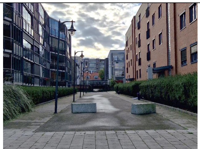
Figur 4.20 Uteoppholdsarealer tilknyttet Fleischer brygge. Jernbanen og eldre bebyggelse i Storgata skimtes i enden.
