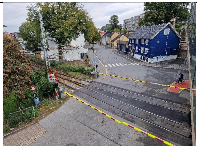
Figur 4.18 Jernbaneovergangen til Storgata, som er en del av KULA-området, og et noe uryddig bygulv.
