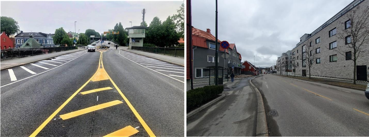
Figur 1.6 Dagens kanalbru med reduksjon av kjørefelt med ny veioppmerking, Foto: Østfold fylkeskommune. Helgerødgata ved Harald Hårfagres gate.
