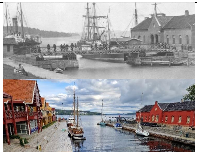
Figur 4.16 Tollboden, rødt bygg, i 1855 og 2023 (historisk foto: Mossebibliotekene).
