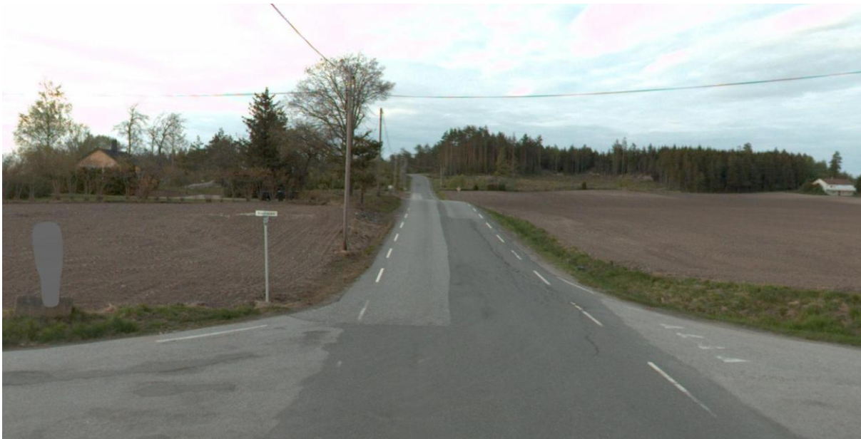
Figur 5 Fv. 381 utsyn sørover fra krysset mellom fv. 381 Seppoveien og fv. 1084 Elindveien (Vegbilder, Statens vegvesen)
