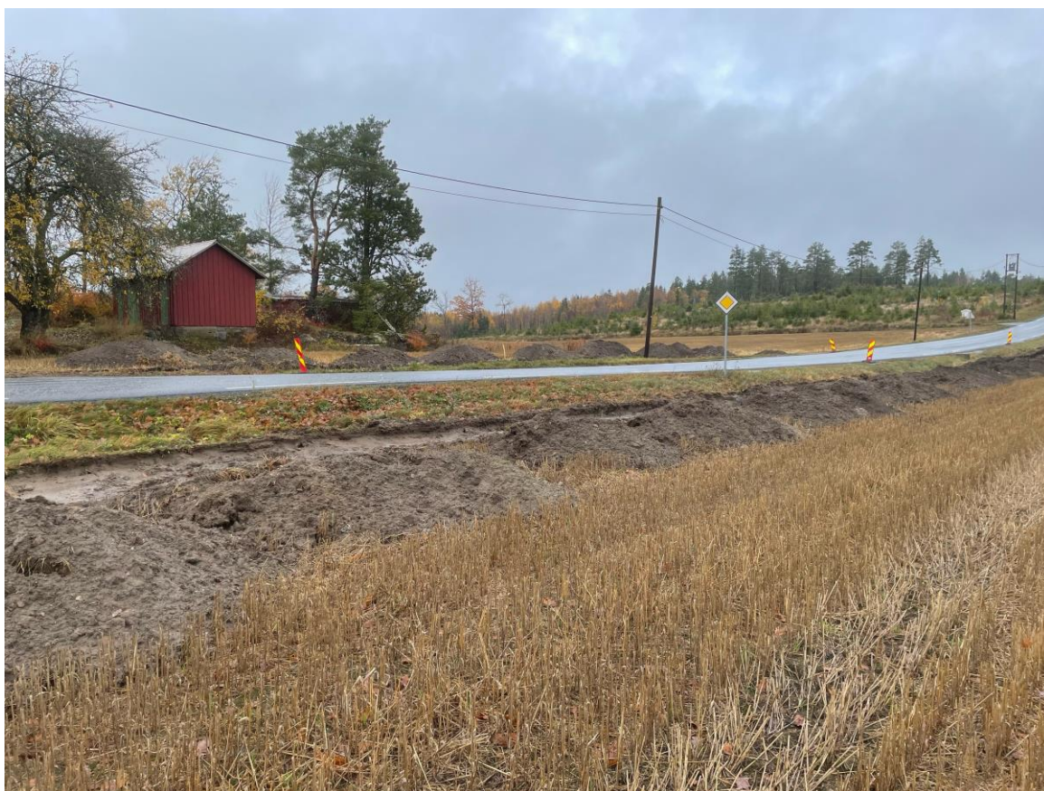
Figur 27: Fotografert mot sjakt 8 i forkant. Tatt mot nordvest.
