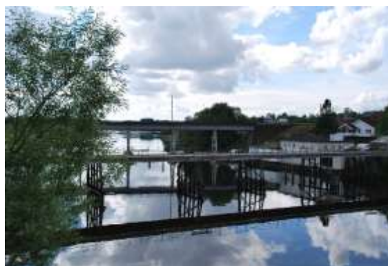
Figur 7-1: Gamle Rolvsøysund bru
