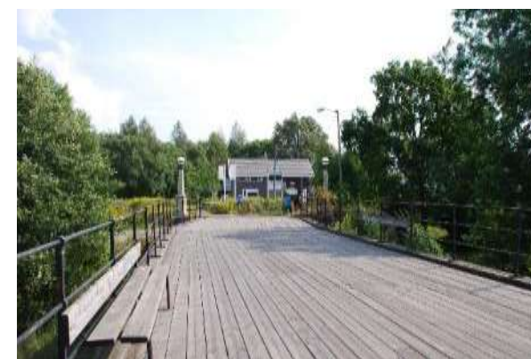
Figur 7-8: Gamle Rolvsøysund bru
