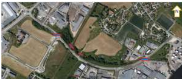
Figur 6-21: Evjobekken går under veg og jernbane i rør. Det kan bli behov for å utvide kapasiteten i krysningspunktene. Reguleringsplanen omfatter områdene fram til jernbanen.
