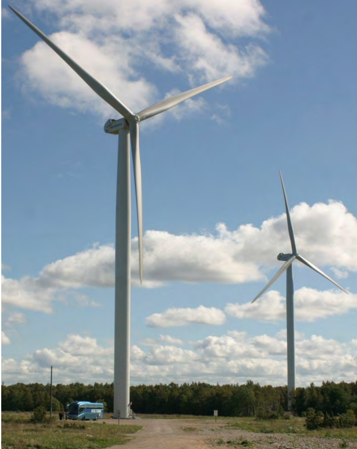
Moderne vindturbiner, hver med generatoreffekt på 2-3 MW.
