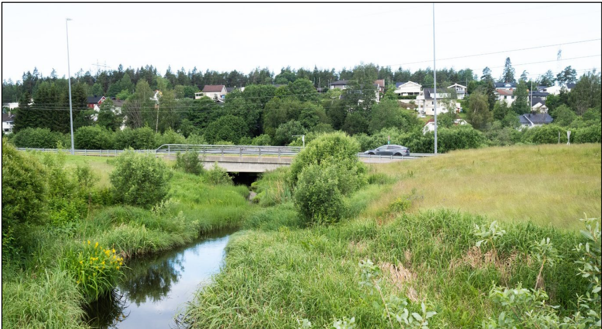
Åpen bekk under veikulvert. Fotograf: Åse Holte, Asplan Viak
