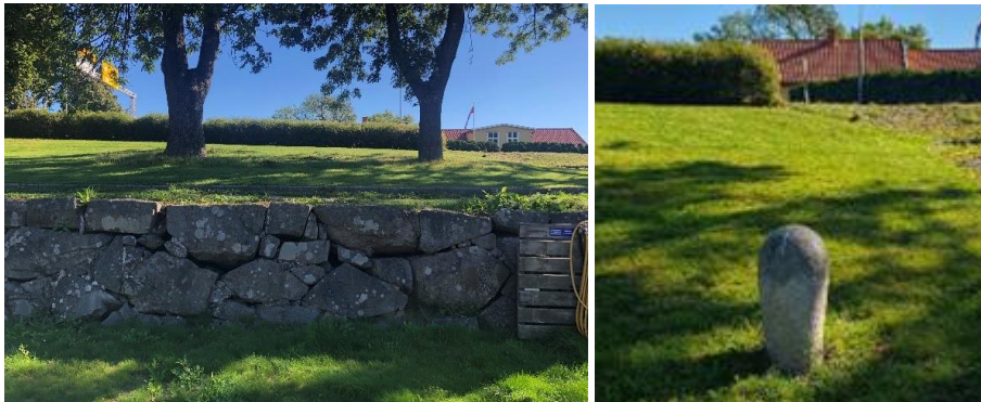
Figur 67 Natursteinsblokker langs kanalen og steinmarkører fra 1855 er plassert på begge siden av kanalen på sørsiden av brua. Norconsult våren 2023.
