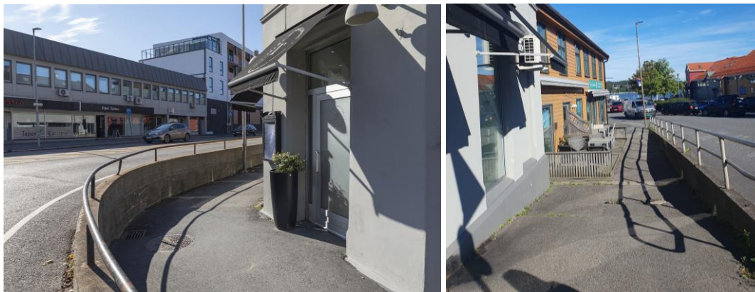
Bildet til høyre er av støttmuren utenfor Værftsgata 2, og til venstre videre utenfor 2B. Foto Norconsult våren 2023.
