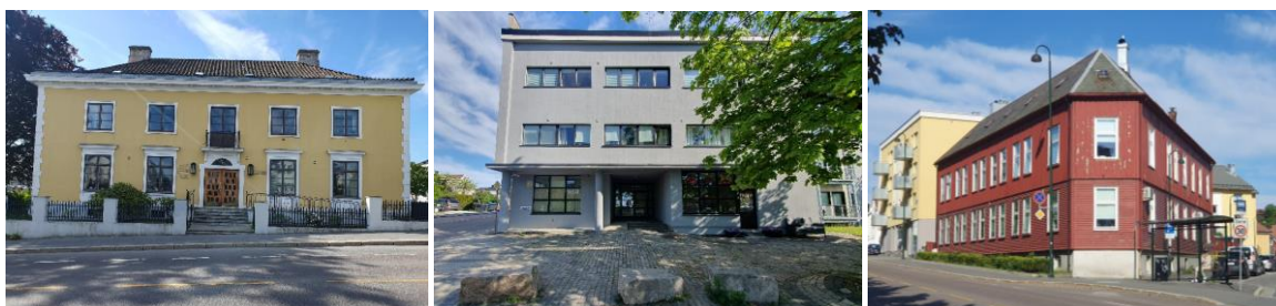
Figur 61 Bilde til venstre av tidligere administrasjonsbygning til Moss Glassverk i Cort Adlers gate 8. Bilde i midten er Gimle kino sett fra Helgerødgate. Bilde til høyre er bygården i Helgerødgate 13 kalles «Snepløgen» og ble fra 1902 til 1960-tallet benyttet som Moss Glassverk sitt hovedkontor. Deretter ble det gjort om til funksjonærbolig for sine ansatte. Foto Norconsult sommer 2023.
