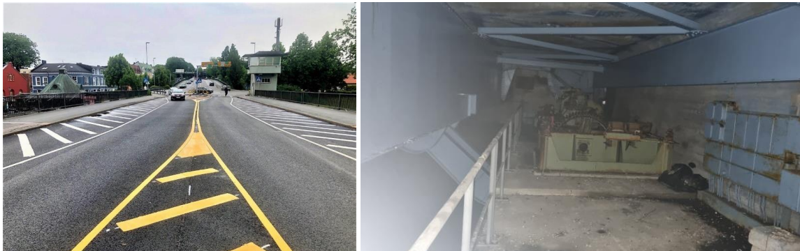
Figur 37 Dagens kanalbru med reduksjon av kjørefelt med ny veioppmerking, Foto Østfold fylkeskommune. Bildet til høyre viser maskinrommet under kanalbrua på vestsiden. Foto Norconsult våren 2023.
