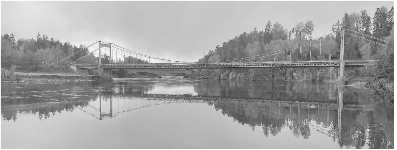
Figur 3 : Dagens bru sett fra nordøst. Skogdekte koller og skråninger rammer inn elvelandskapet. (Foto: Grindaker)
