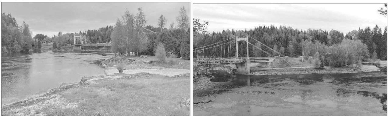
Figur 2-3 Bilde til venstre: Rasteplass på vestsiden av Fossum bro, sett mot nord [befaring]. Bilde til høyre: Rasteplass på vestsiden av Fossum bro, sett mot sørøst [befaring]. Rasteplassen er registrert som viktig friluftslivsområde [delområde FL3].
