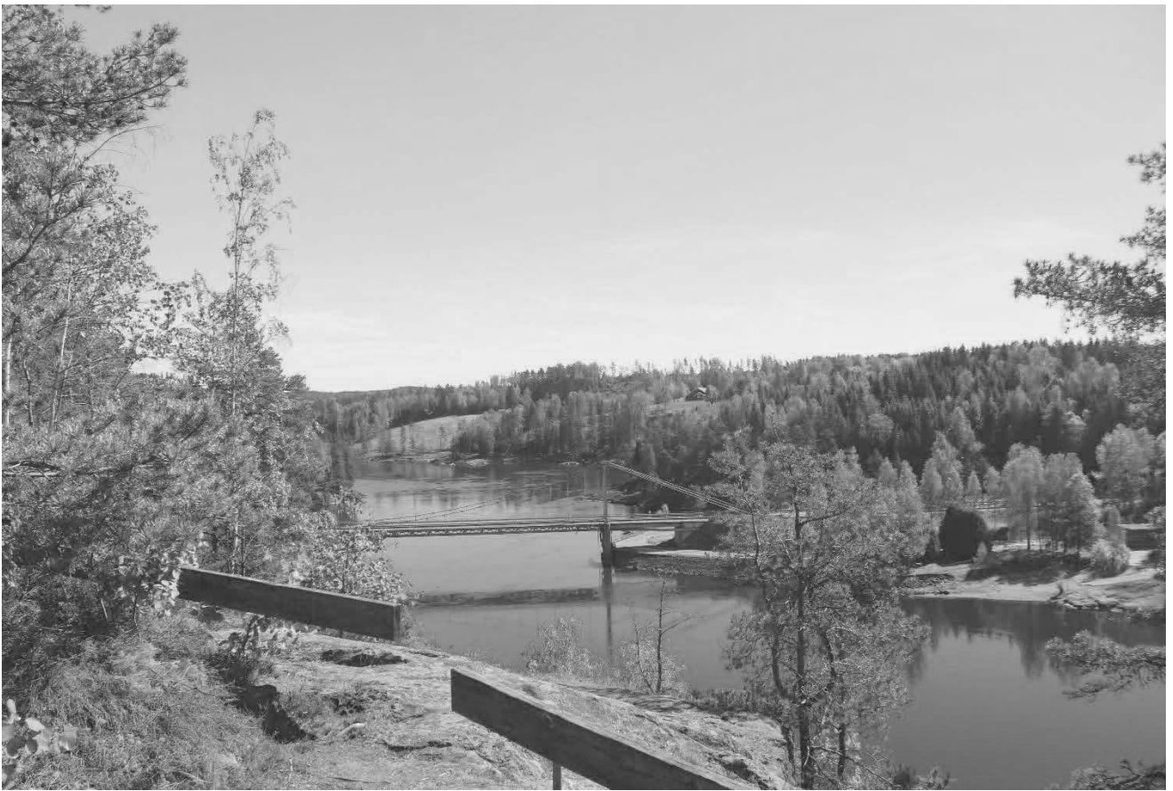
Utsikt mot nye Fossum bru fra toppen av Fossum brogalleri. Tatt mot øst.
