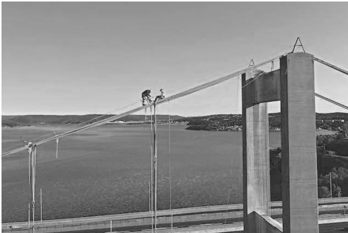
Figur 6-4-Bilde fra rivingen av Varoddbrua (kilde: Statens Vegvesen)
