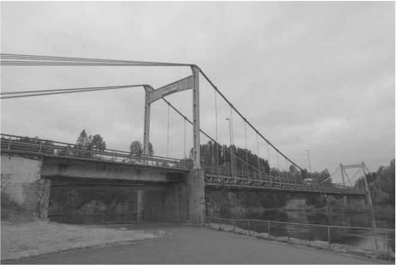
Figur 6-2 Bilde av eksisterende bru (kilde: Hovedinspeksjonsrapport – Aas-Jakobsen 2021)
