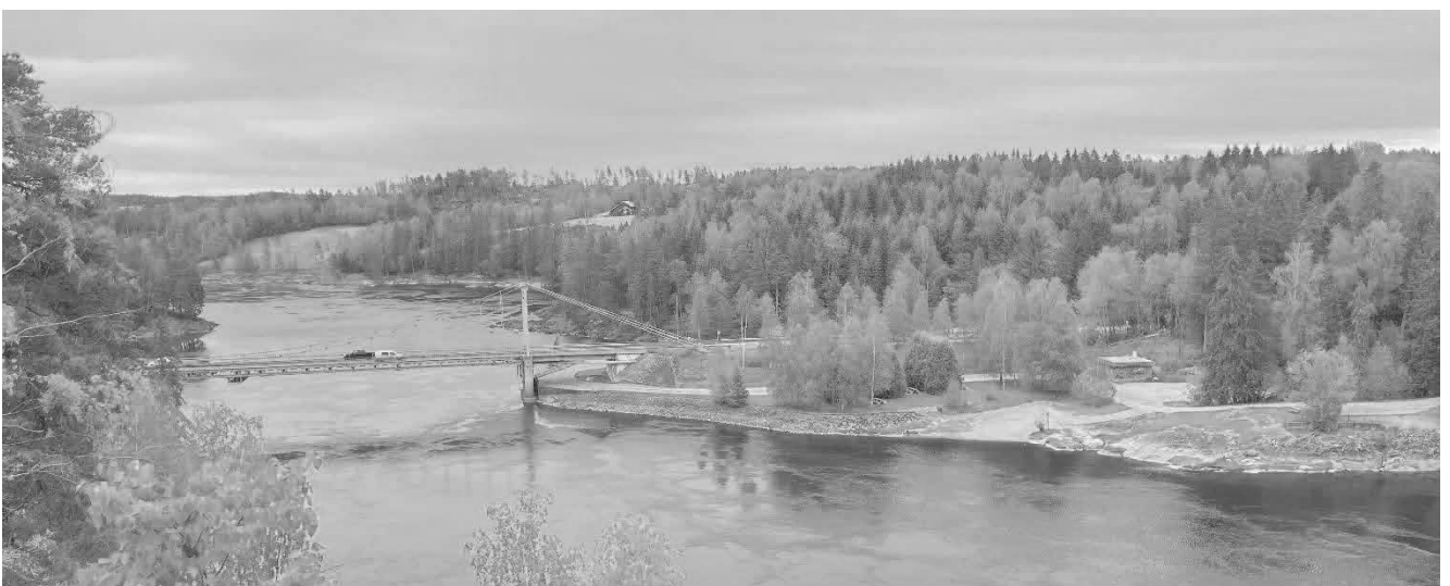
Figur 5: Dagens bru sett fra nordvest. Rasteplass med tilhørende anlegg, samt brokonstruksjon preger landskapet på sydsiden av elven. (Foto: Grindaker)
