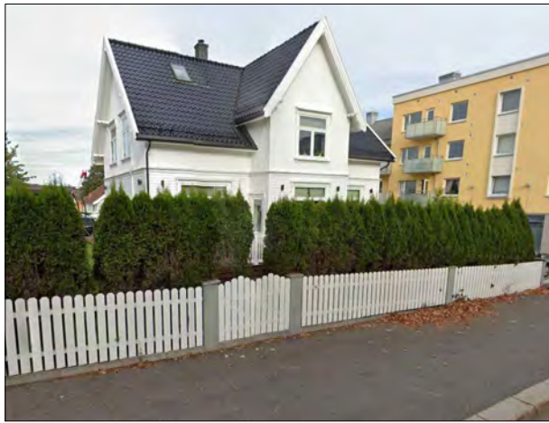
Tordenskiolds gate 3. Eksisterende murkant og gjerde, sett fra Helgerødgate. Kant og gjerde må flyttes ca 2,7 m innover, pga fortausutvidelse, driftsareal og frisktskrav.
