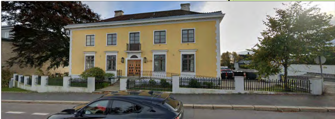
Cort Adellers gate 8 med forhage, støttemur med stolper og gjerde. Mur må flyttes ca 0,85 - 1,44 m innover mot fasaden, slik at en minimumsbredde på 2,5 m på nytt fortau oppnås. Foto: Google Streetview
