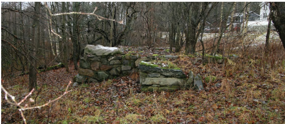
Figur 47 Grunnmur/stenmur rett nord for Lia. Foto: COWI AS, nov. 2019.
