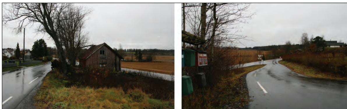
Figur 51 Bildene viser eksisterende kryss fylkesveg 119 Larkollveien x fylkesveg 1064 Klosterveien. Til høyre er den søndre armen av Klostervegen, bilde et tatt fra Klostervegen i retning sør. Til venstre er den nordre armen av Klostervegen, bilde tatt fra Klosterveien i retning nord. Foto: COWI AS, nov. 2019.
