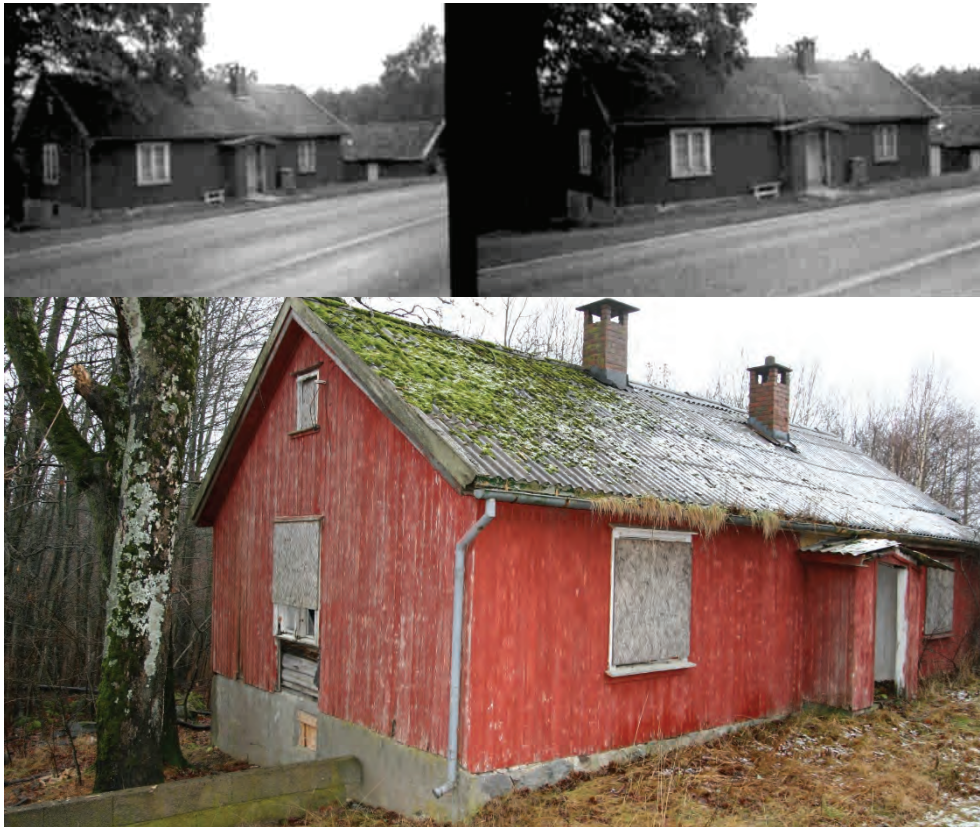
Figur 46 Øverst: Fotografier av bygningen fra 1990. Kilde: SEFRAK-registeret. Nederst: Lia, COWI AS, nov. 2019.
