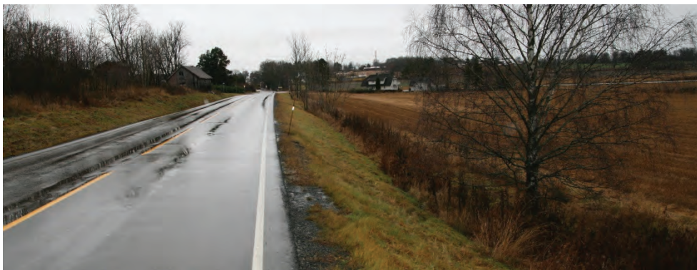
Figur 50 Fylkesveg 119 Larkollveien er i dag uten tilrettelegging for myke trafikanter, med minimalt skulderareal til gående og syklende. Foto: COWI AS, nov. 2019.
