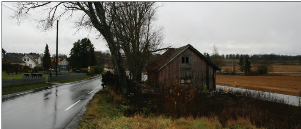
Figur 48 Hønehuset sett fra sør, beliggende mellom Larkollveien i øst og nordre del av Klosterveien. Foto: COWI AS, nov. 2019.
