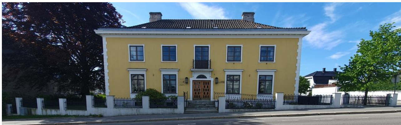
Figur 5-15 – Eksisterende støttemur ved Moss Glassverk Administrasjonsbygg.
