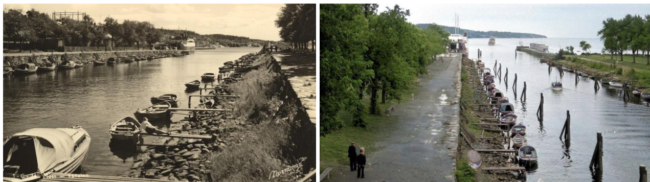
Figur 1-7 Bildet til venstre er tatt fra vestsiden av Kanalparken på 1950-tallet. Her er en nedre rekke med steinblokker synlig i vannkanten før det kommer mindre steiner og en ny rekke med steinblokker er fundamentet for gangvegen. Bildet til høyre er tatt mot sør på den nye kanalbrua i 1957. Bildet viser rekken av steinblokker med et asfaltdekke over. Nedenfor dette er det i dag anlagt en ny flate med asfalt som i dag fungerer som brygge for småbåter. Hentet fra Mossehistorien.no
