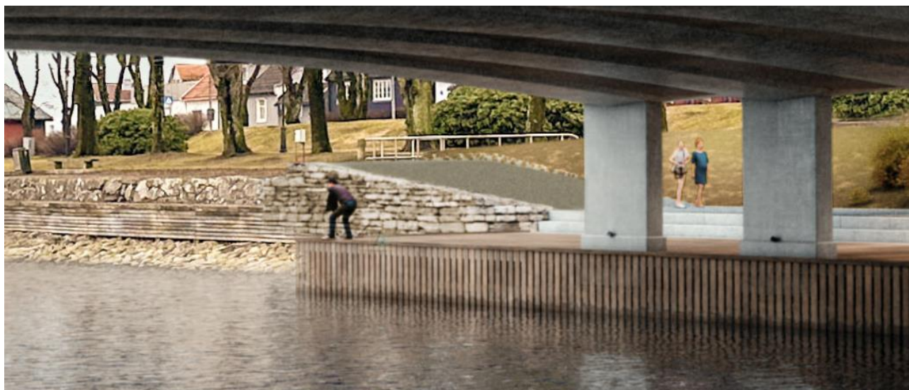
Figur 5-24 – Utsnitt av arkitektillustrasjon for bru som viser nedramping av turveg og tørrmur ved bru og steintrapp og brygge under bru.
