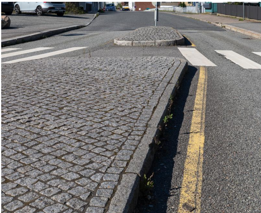
Figur 15-2 Trafikkøylene ved rundkjøringen har smågatestein satt i løsmasser. Gjenbrukes på tilsvarende måte i nytt anlegg.
