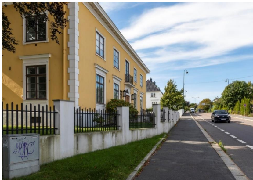
Figur 13-8 Eksisterende mur og gjerde foran Cort Adellers gate 8. Utvidet veianlegg vil forskyve innerkant av fortau nærmere bygg, og mur/ gjerde må bygges opp på nytt, ca. 1,25 m lenger inn. Se også tegning J032 og K810.
