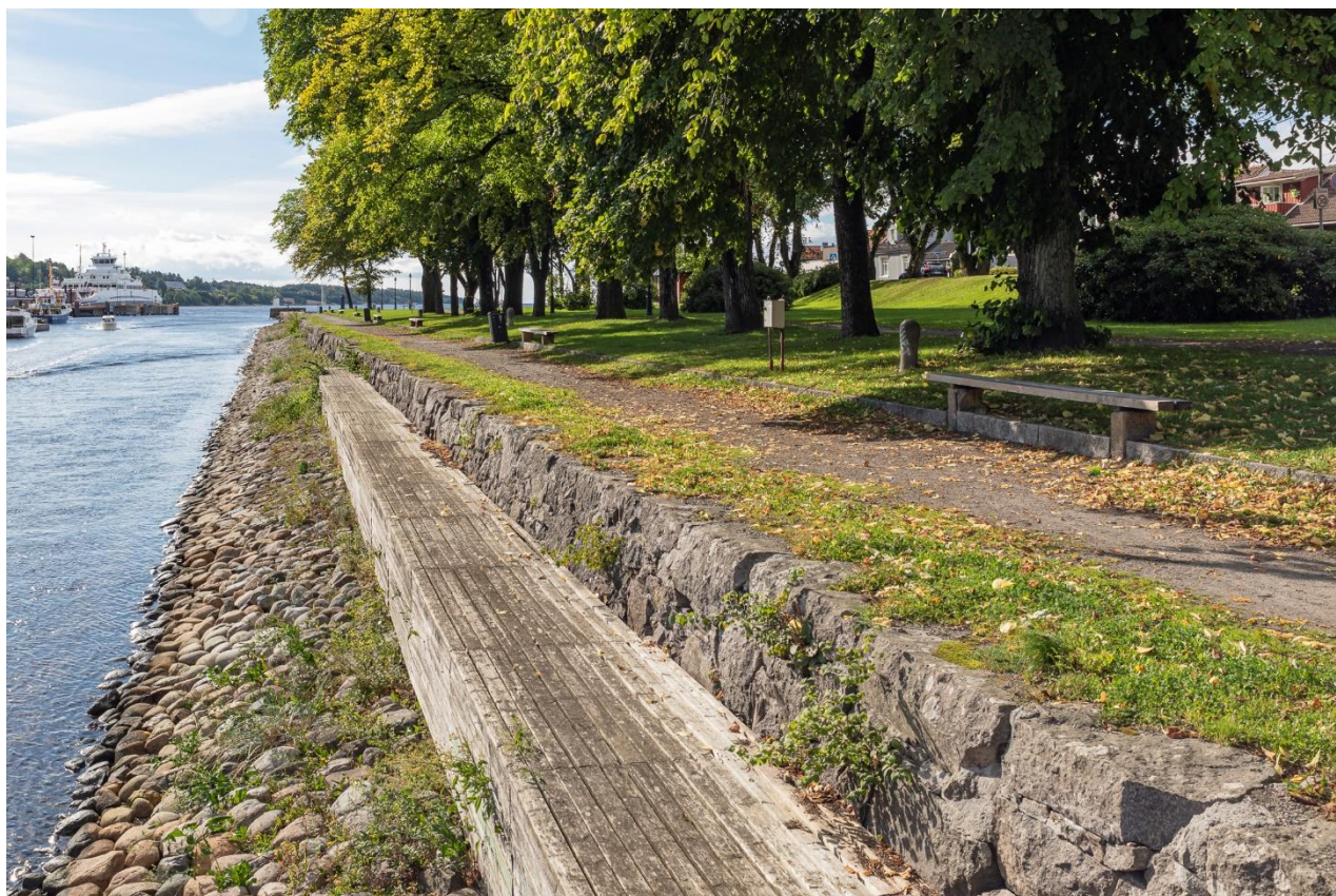
Figur 13-2 Tørrmur langs vestre kanalbredd. Også steinplastringen langs kanalen er gammel, og skal ivartetas i anleggsperioden. Den viste trekonstruksjonen skal ikke gjenoppbygges.
