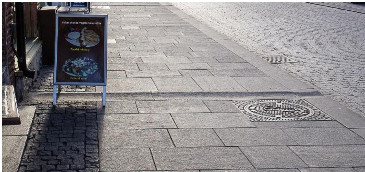
Figur 11-12 Eksempel på fortausvannrenne fra taknedløp ut over kantstein til kjørebane.
