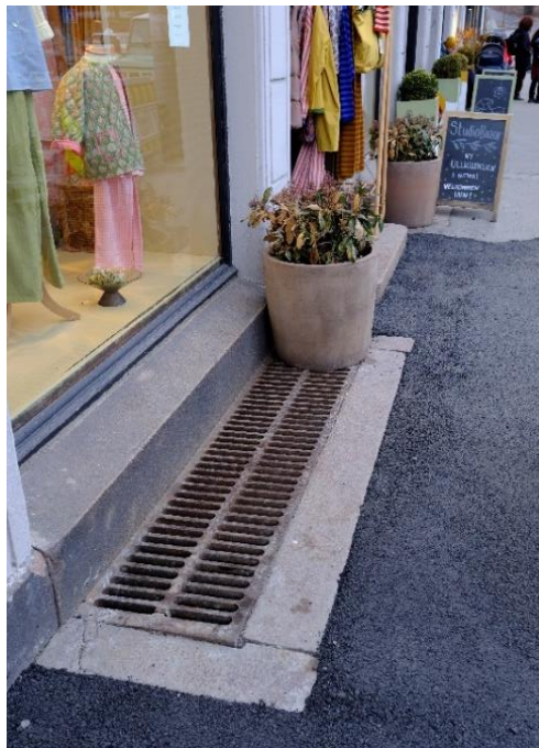
Figur 13-7 Eksempel på area med ristoverdekning. Til venstre; stållrist. Til høyre; støpejernsrist. Ristene ligger i en ramme av granitt. Dersom det benyttes en stållramme, skal denne monteres langs ytterkanten av dagens betongramme. Dermed kan det asfalteres helt inn til ristrammen, uten synlig betong i overflaten.
