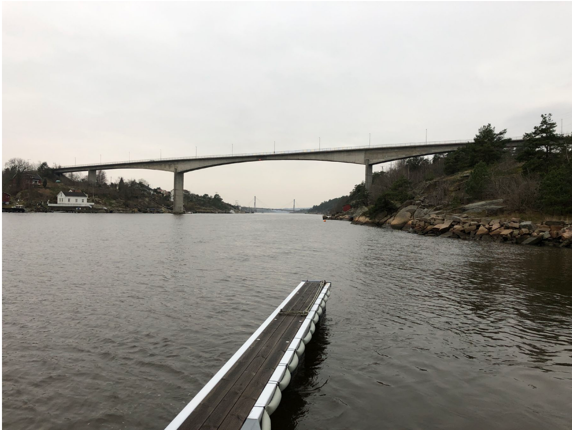
Figur 24 Bildet viser eksisterende bru, sett fra Sandbukta (Foto: Sweco Norge AS)
