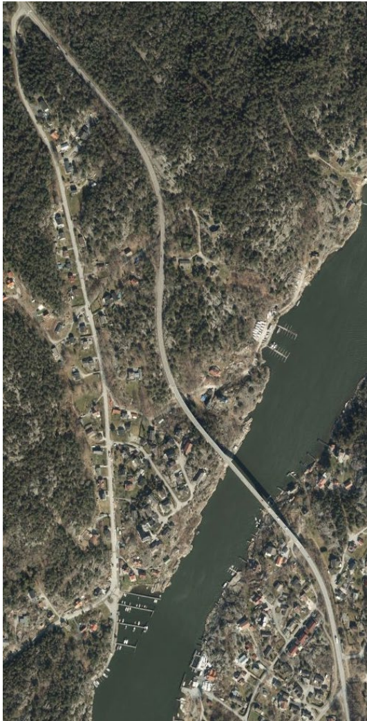
Figur 66 Kartutsnittet viser dagens Kjøkøysund bru og omkringliggende områder. (Kilde: Norgebilder.no)
