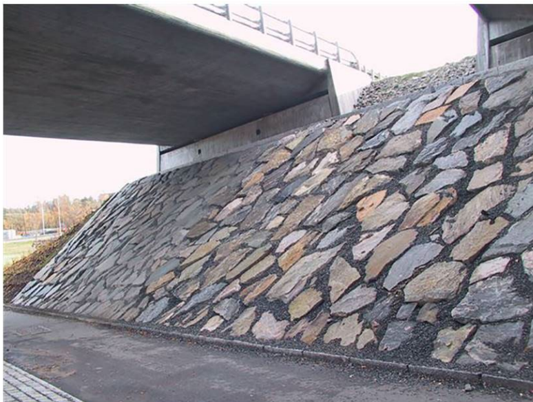
Figur 34 Eksempel på steinplastring under bruskylgje (Foto: Sweco Norge AS)
