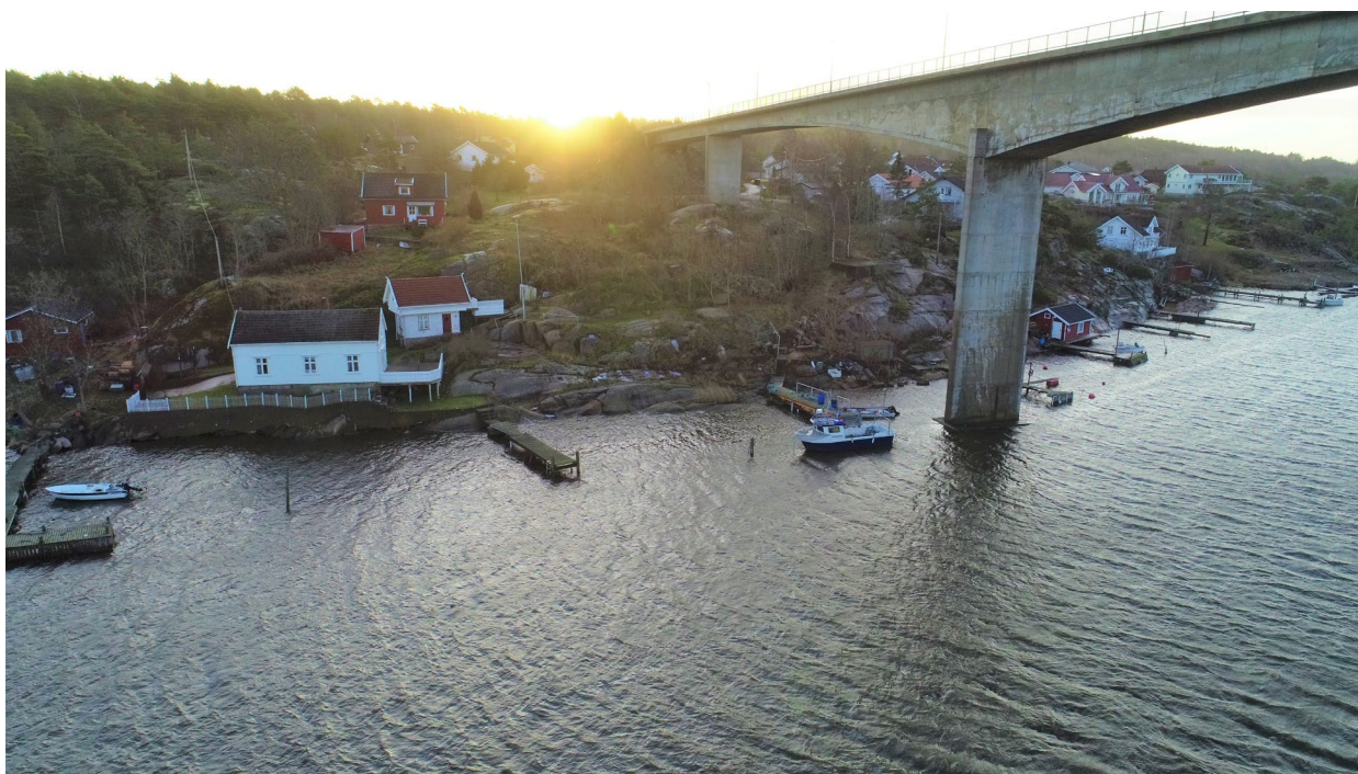
Figur 41 Rekvin Nordre sett fra dagens bru. (foto: Sweco Norge AS)
