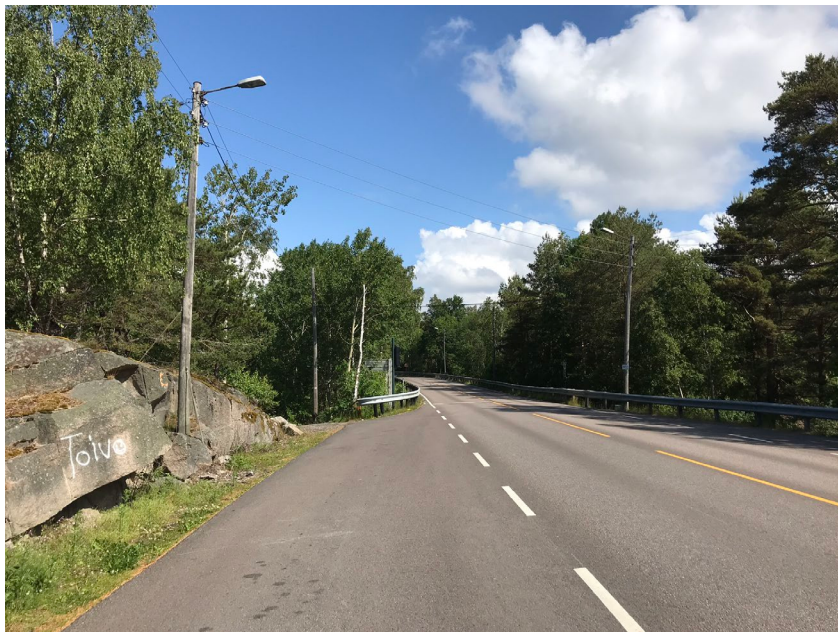
Figur 73 Kråkerøy v/bussholdeplasser sett nordover. (Foto: Sweco Norge AS)
