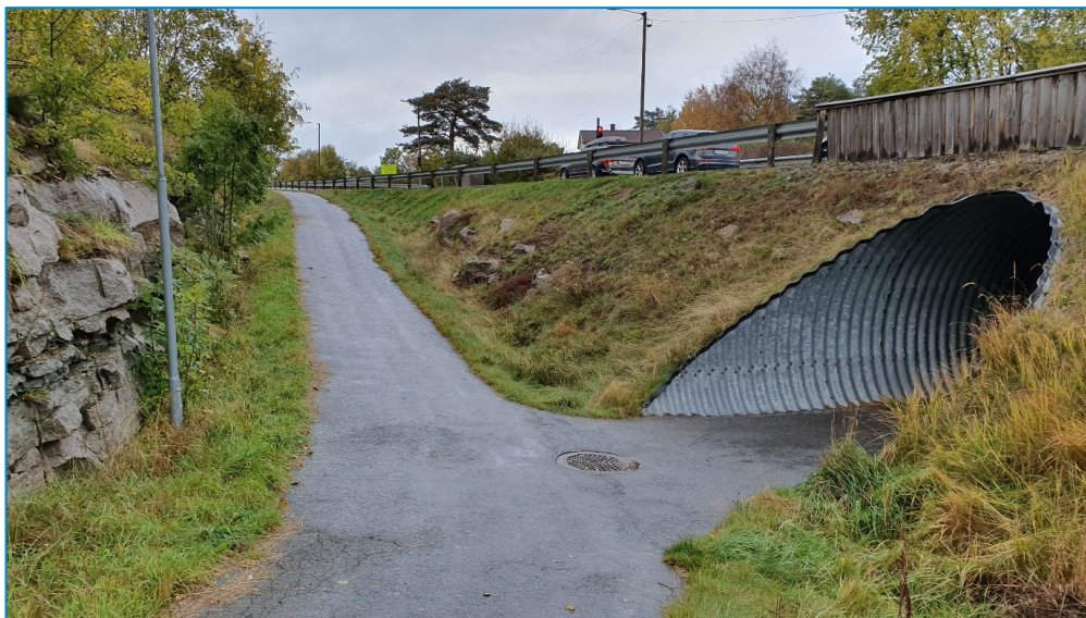
Figur 12 Gang- og sykkelundergang mellom Kjerreveien og Nordre Rekin (Foto: Sweco Norge AS)
