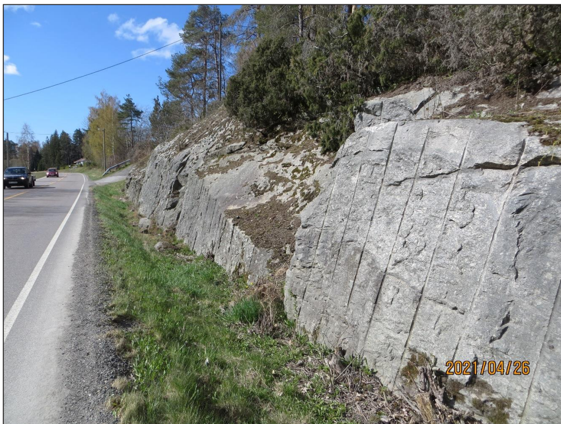
Figur 17: Eksisterende bergskjæring langs profil 1000-1060. Granittisk-kvartsdiorittisk biotittgneis massivt med godt til svært god bergmassekvalitet.
