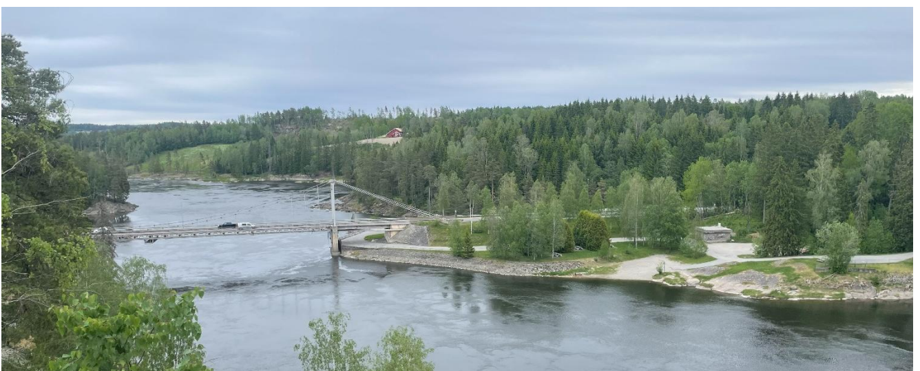
Figur 5: Dagens bru sett fra nordvest. Rasteplass med tilhørende anlegg, samt brokonstruksjon preger landskapet på sydsiden av elven. (Foto: Grindaker)
