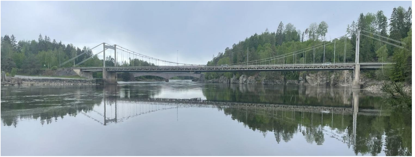
Figur 3 : Dagens bru sett fra nordøst. Skogdekte koller og skråninger rammer inn elvelandskapet. (Foto: Grindaker)
