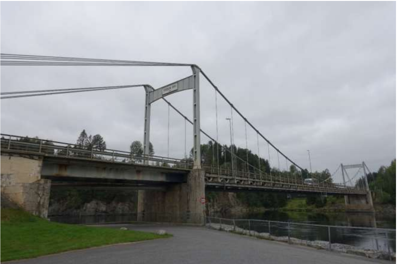
Figur 6-2 Bilde av eksisterende bru (kilde: Hovedinspeksjonsrapport – Aas-Jakobsen 2021)
