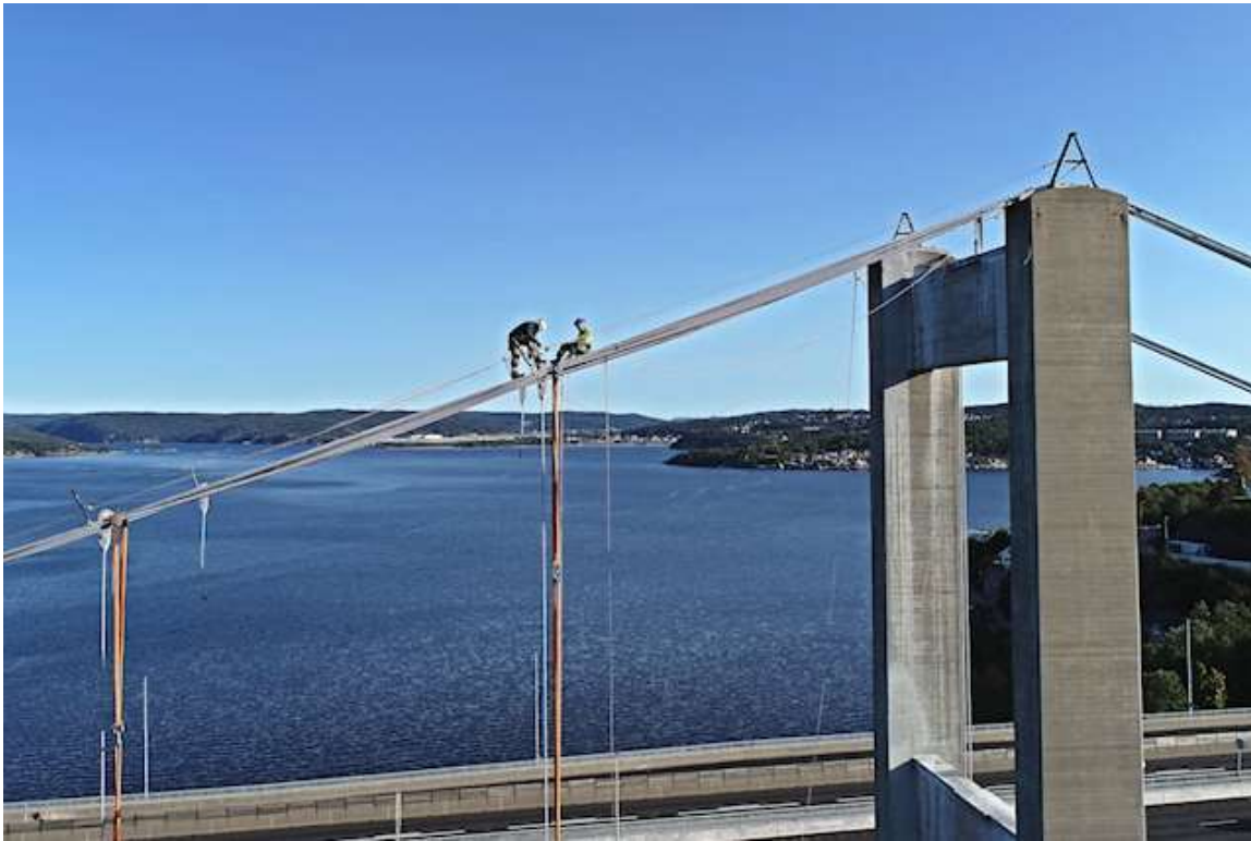
Figur 6-4-Bilde fra rivingen av Varoddbrua (kilde: Statens Vegvesen)
