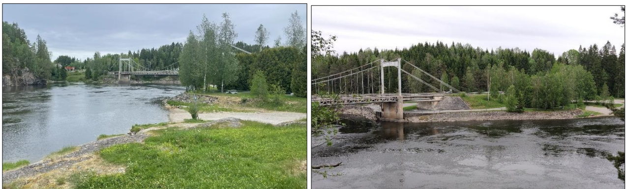
Figur 2-3 Bilde til venstre: Rasteplass på vestsiden av Fossum bro, sett mot nord [befaring]. Bilde til høyre: Rasteplass på vestsiden av Fossum bro, sett mot sørøst [befaring]. Rasteplassen er registrert som viktig friluftslivsområde [delområde FL3].
