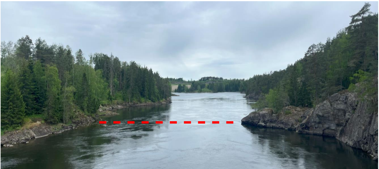
Figur 7-7: Elva sett medstrøms fra Gamle Fossum bru. Rød strek markerer innsnevringen i elveløpet som bestemmer vannstanden ved Fossum bru. Kilde: DHI
