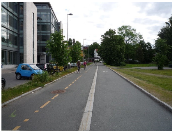
Figur 5-3: Sykkelveg med fortau på Skøyen i Oslo
