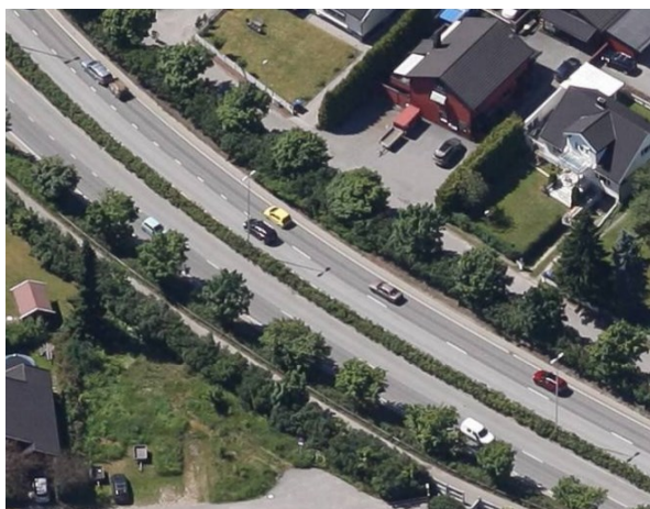
Figur 4-2: Rolvsøyveien har grønne rammer. Skråfoto: Fredrikstad kommune
