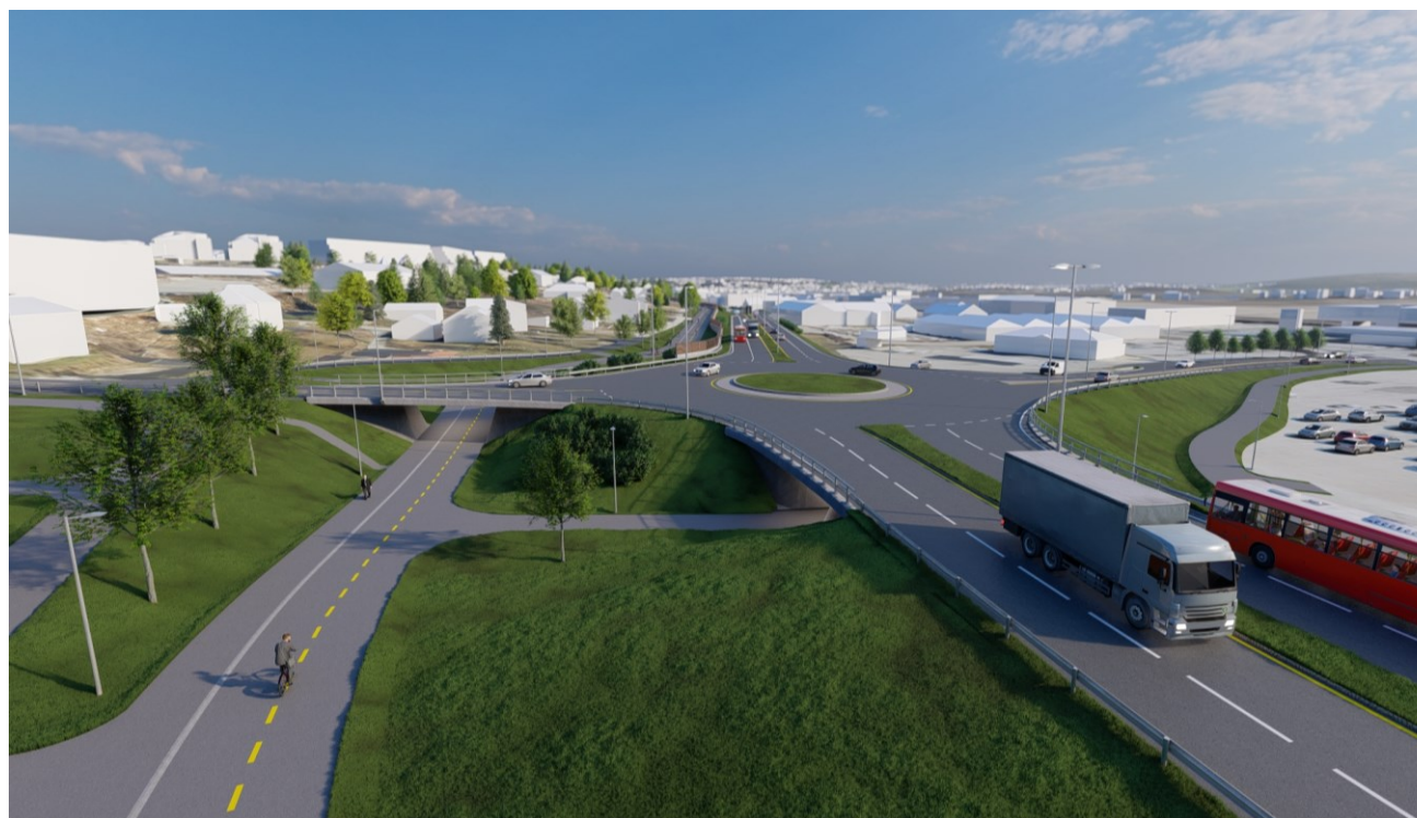
Figur 5-10: Planskilte kryssinger gir behov for arealer utenfor selve veganlegget
