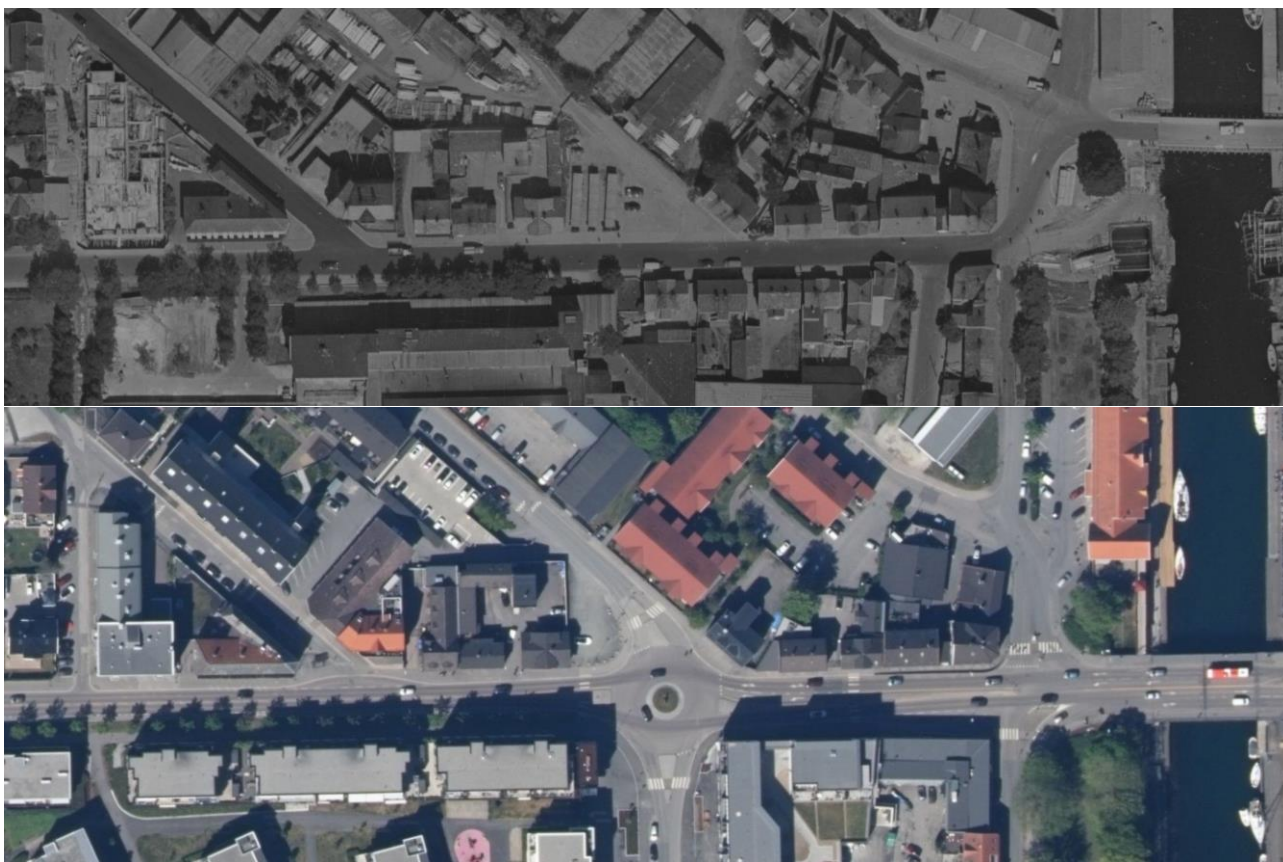
Figur 4-24 Det øverste bildet viser delområdet på flyfoto fra 1955 men påbegynt anleggsområde til ny kanalbru, mens det nederste viser samme utsnitt i 2022. Hentet fra norgebilder.no.
