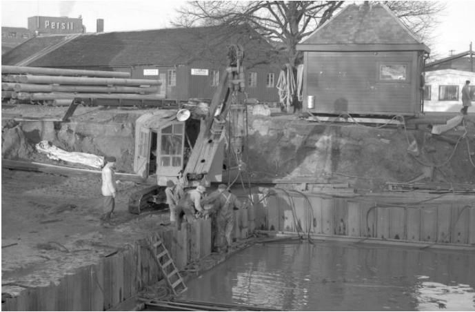
Figur 4-48 Bildet til venstre viser anleggsarbeidene i 1954 hvor kanalen ble spuntet og stengt under anleggsarbeidene. Hentet fra Mossehistorien.no
