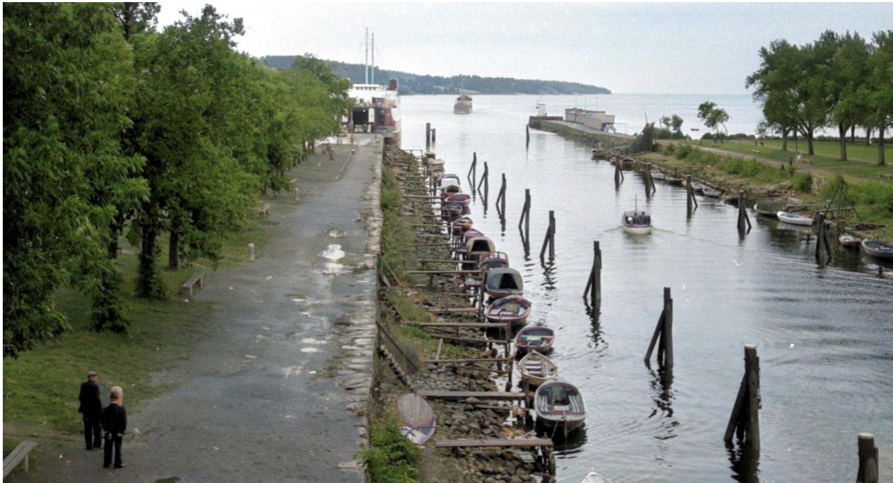
Figur 4-43 Bildet er tatt mot sør på den nye kanalbrua i 1957. Værlesanden er området på begge sider av kanalen. Som en følge av kanalmoloen ut i Værlebukta begynte det å danne seg en fin sandstrand på vestsiden av moloen. Dette ble etter hvert det populære Sjøbadet. Hentet fra Mossehistorien.no
