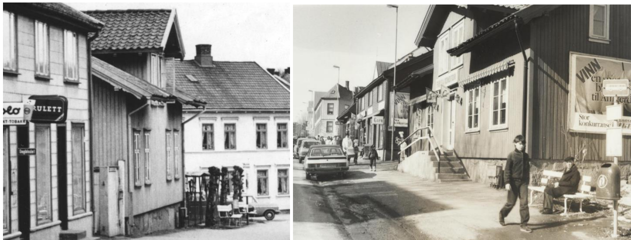
Figur 4-14 Bildet viser Helgerødgata 5a uten trappeinngang og inngangspartiene til Helgerødgata 7b rundt 1960. Bildet til høyre viser samme bygninger sett fra øst på tidlig 80-tallet. Hentet fra Mossehistorien.no
