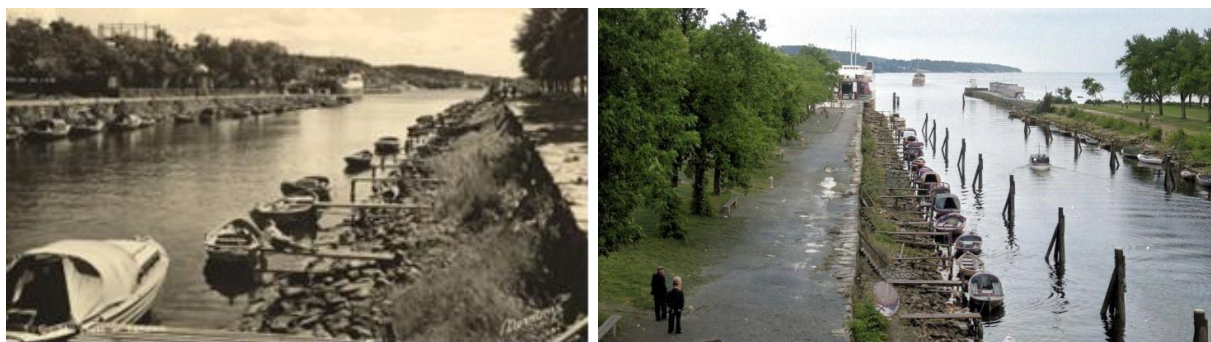
Figur 7-4 Bildet til venstre er tatt fra vestsiden av Kanalparken på 1950-tallet. Her er en nedre rekke med steinblokker synlig i vannkanten før det kommer mindre steiner og en ny rekke med steinblokker er fundamentet for gangveien. Bildet til høyre er tatt mot sør på den nye kanalbrua i 1957. Bildet viser rekken av steinblokker med et asfaltdække over. Nedenfor dette er det i dag anlagt en ny flate med asfalt som i dag fungerer som brygge for småbåter. Hentet fra Mossehistorien.no
