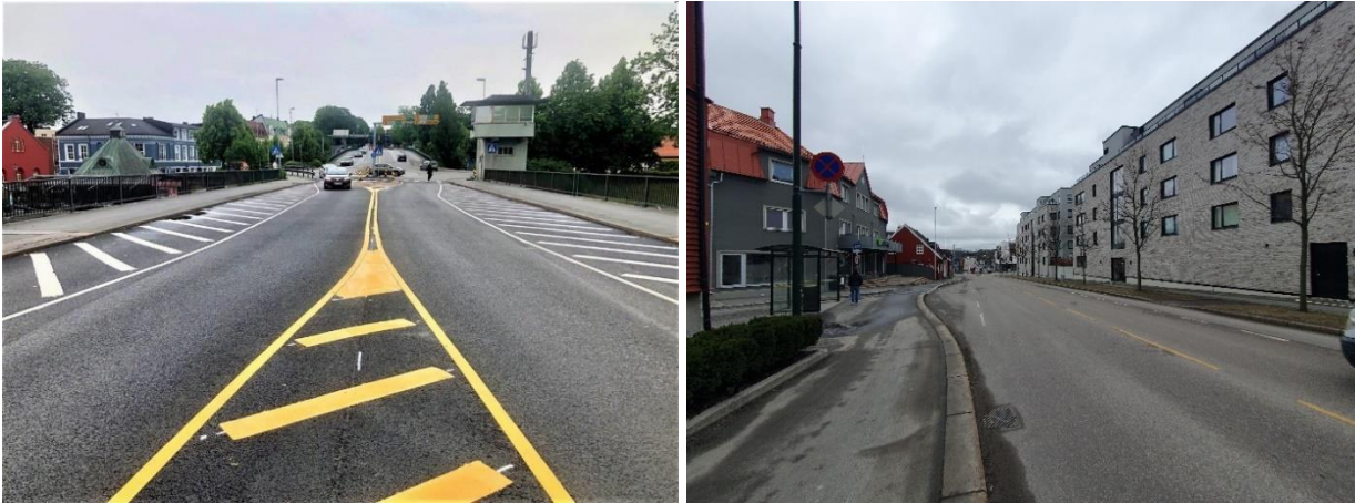
Figur 1-6 Dagens kanalbru med reduksjon av kjørefelt med ny veioppmerking, Foto Østfold fylkeskommune. Helgerødgata ved Harald Hårfagres gate. Foto Østfold fylkeskommune og Norconsult våren 2023.
