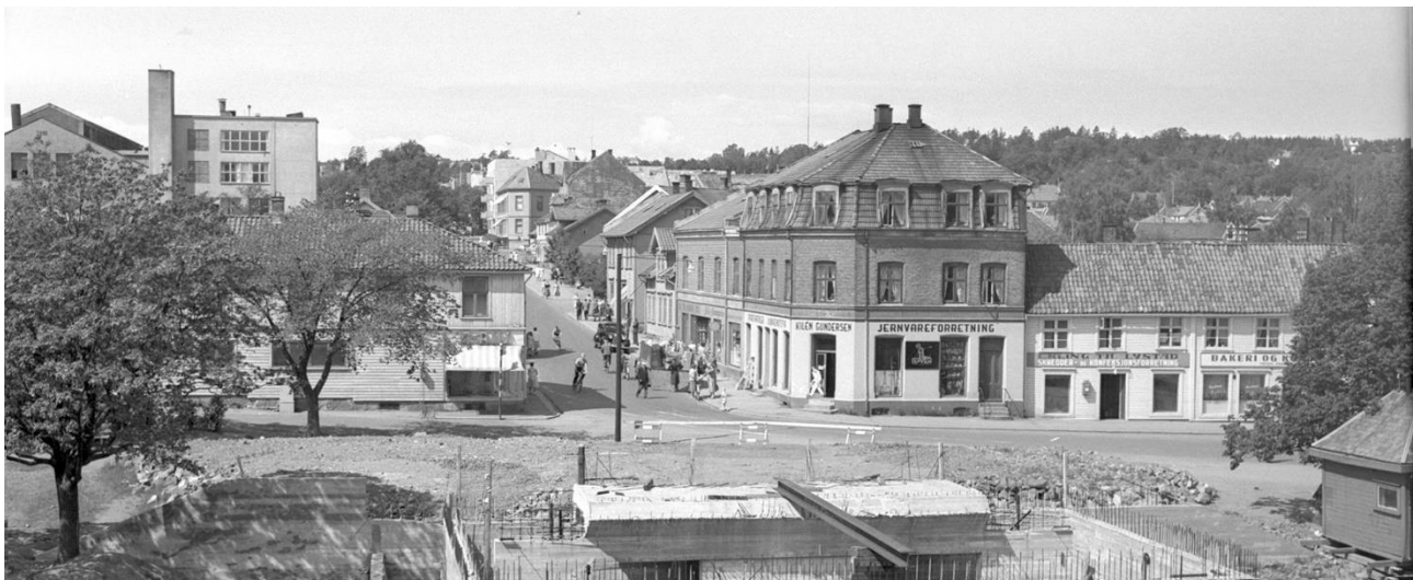
Figur 4-20 Fotografiet viser bredden på fortauet i Helgerødgata hvor man kunne gå fire mann i bredden i 1956. Høyden på veien ligger lavere i terrenget, vises spesielt ved murgården. Hentet fra Mossehistorien.no
