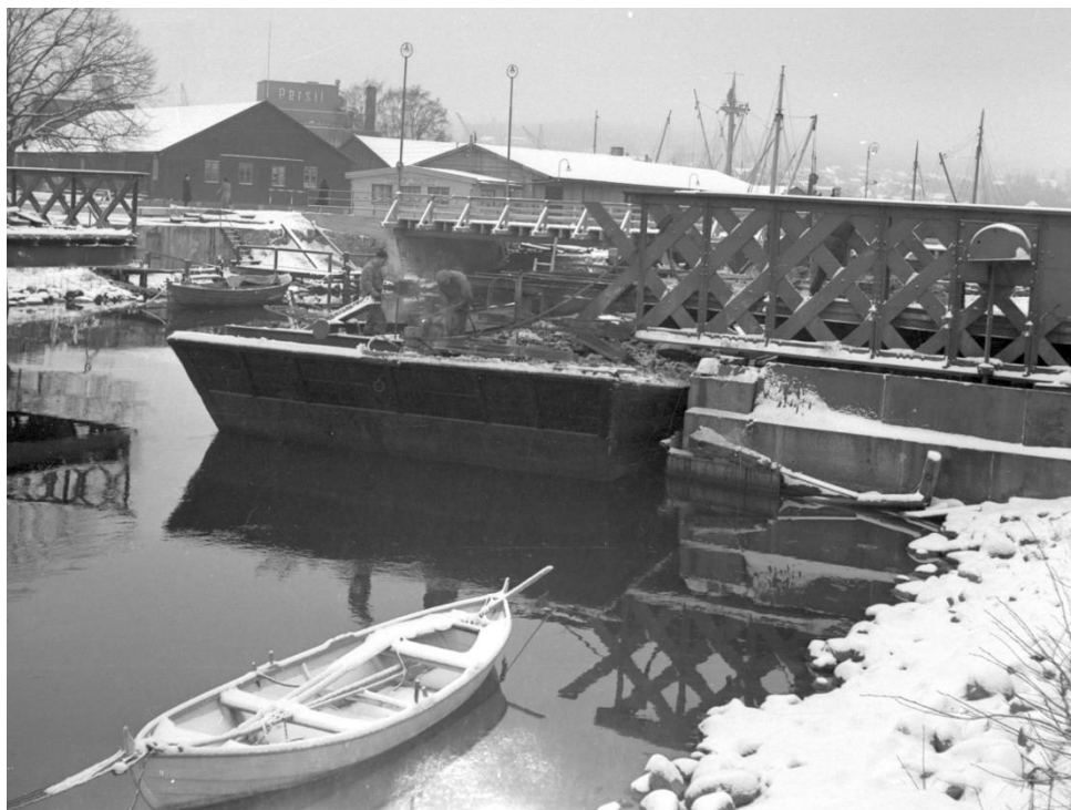
Figur 4-51 Ved demontering og byggingen av dagens bru ble det brukt lektere. Foto mossehistorien.no
