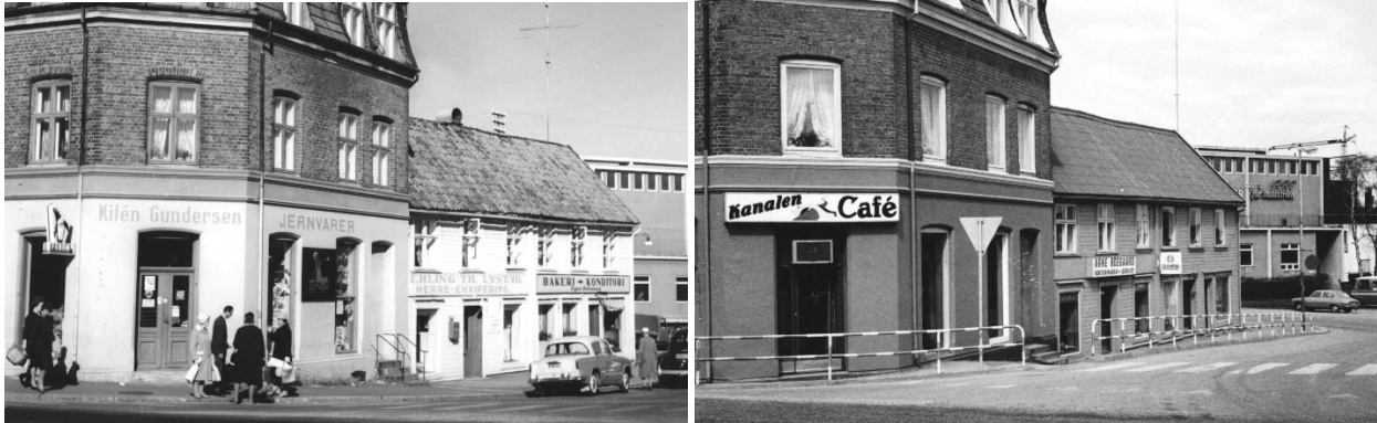
Figur 4-21 Murgården og tregården ble benyttet til handel både på bildet til høyre fra 1963 og til venstre fra 1980. Fotografiet til venstre er tatt like før forhøyningen av veien påvirket inngangspartiene til gårdene. Hentet fra Mossehistorien.no
