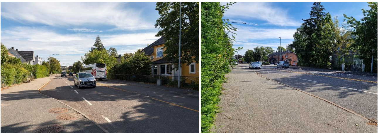
Figur 4-9 Helgerødgata sett fra nordsiden av veien og vestover. Foto Norconsult våren 2023.
