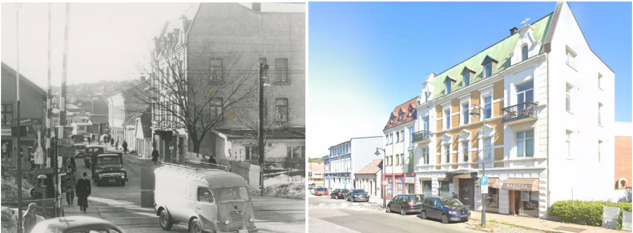
Figur 4-39 Bildet til venstre viser Jeløgata ca. 1960-tallet fra før Rådhusbrua ble etablert, og bildet til høyre viser gata i dag. Bildene viser at det har blitt etablert en ny bygård i Jeløgata 8 og at hjørnebygården i Jeløgata 4 har fått et oppløft på tak. Hentet fra digitalmuseum.no
