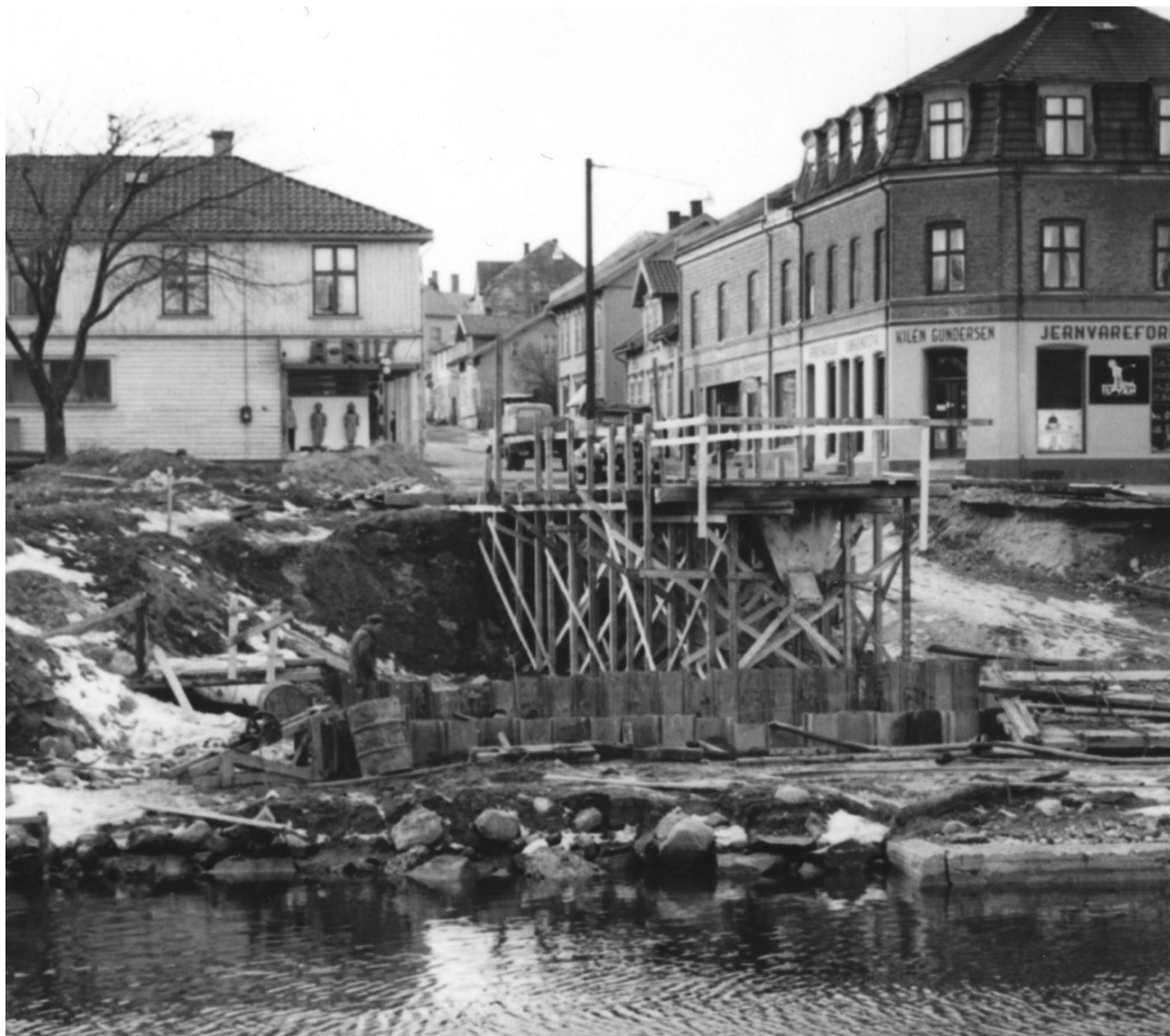
Figur 4-50 Klargjøring før bygging i 1955. Foto mossehistorien.no
