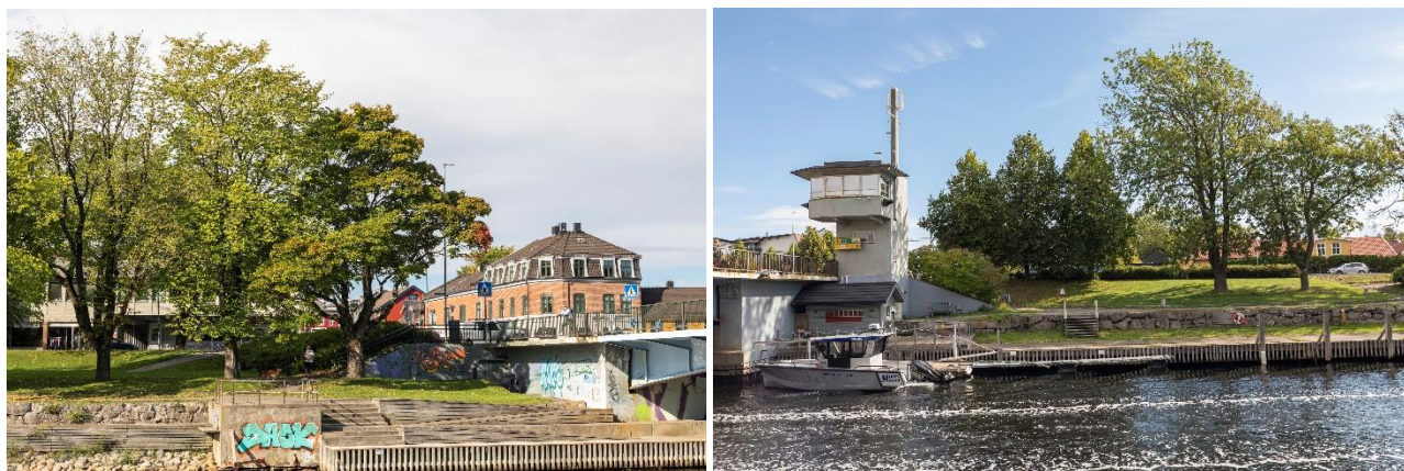
Figur 6-3 Interimsveien og anleggsgjennomføringen vil medføre at de nærmeste trærne til kanalbrua hugges. Foto Norconsult våren 2023.
