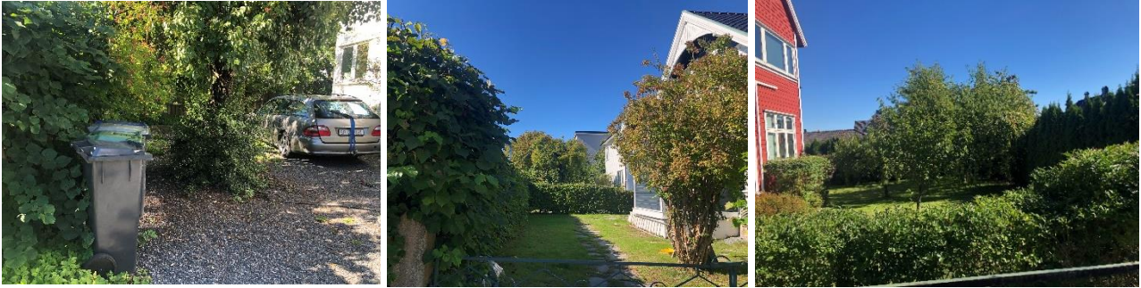
Figur 6-5 Bilder av forhagene til Helgerødgata 31, 29 og 27. Foto Norconsult våren 2023.
