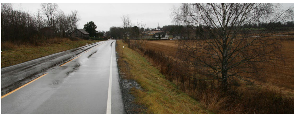
Figur 42 Fylkesveg 119 Larkollveien er i dag uten tilrettelegging for myke trafikanter, med minimalt skulderareal til gående og syklende. Foto: COWI AS, nov. 2019.
