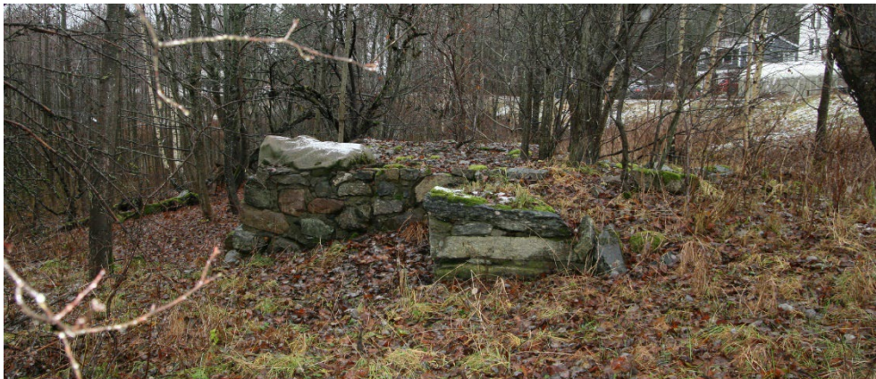
Figur 39 Grunnmur/stenmur rett nord for Lia. Foto: COWI AS, nov. 2019.
