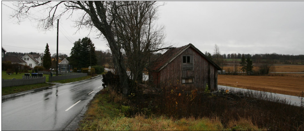
Figur 40 Høsehuset sett fra sør, beliggende mellom Larkollveien i øst og nordre del av Klosterveien. Foto: COWI AS, nov. 2019.
