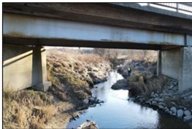
Figur 8-2 Eksisterende plastring under bru.
