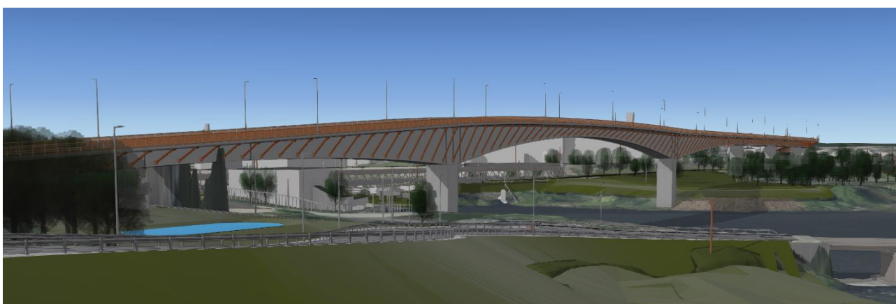
Figur 3-23: Fritt frembygg bru må ha en viss høyde fordi brukassa blir høy. GIS-modell Multiconsult.
