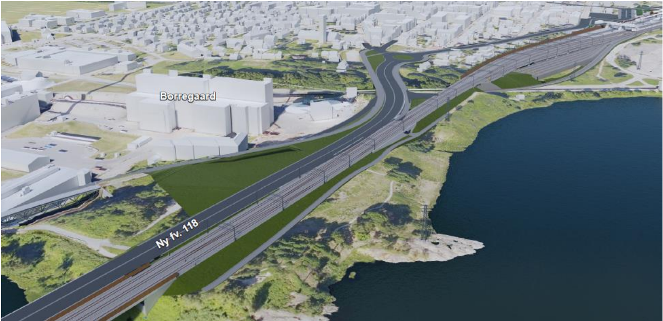
Figur 3-12: Illustrasjon fra IC-prosjektet der vei og jernbane går på en fylling over Tarrisområdet
