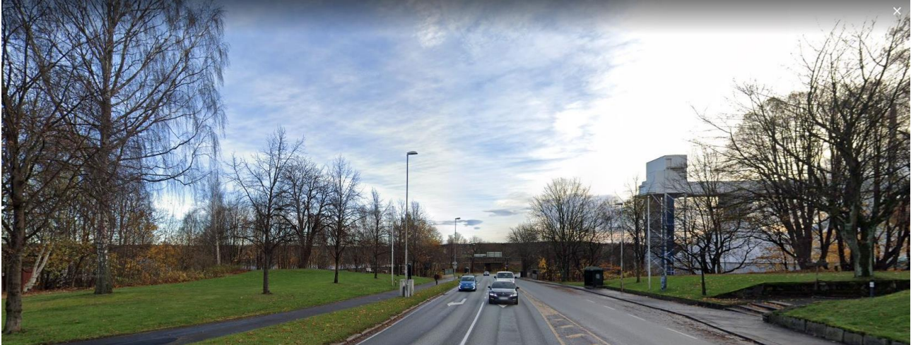
Figur 3-7: Dagens fylkesvei i retning mot Glomma sett fra veien rett øst for nytt kryss med St. Nikolas gate
