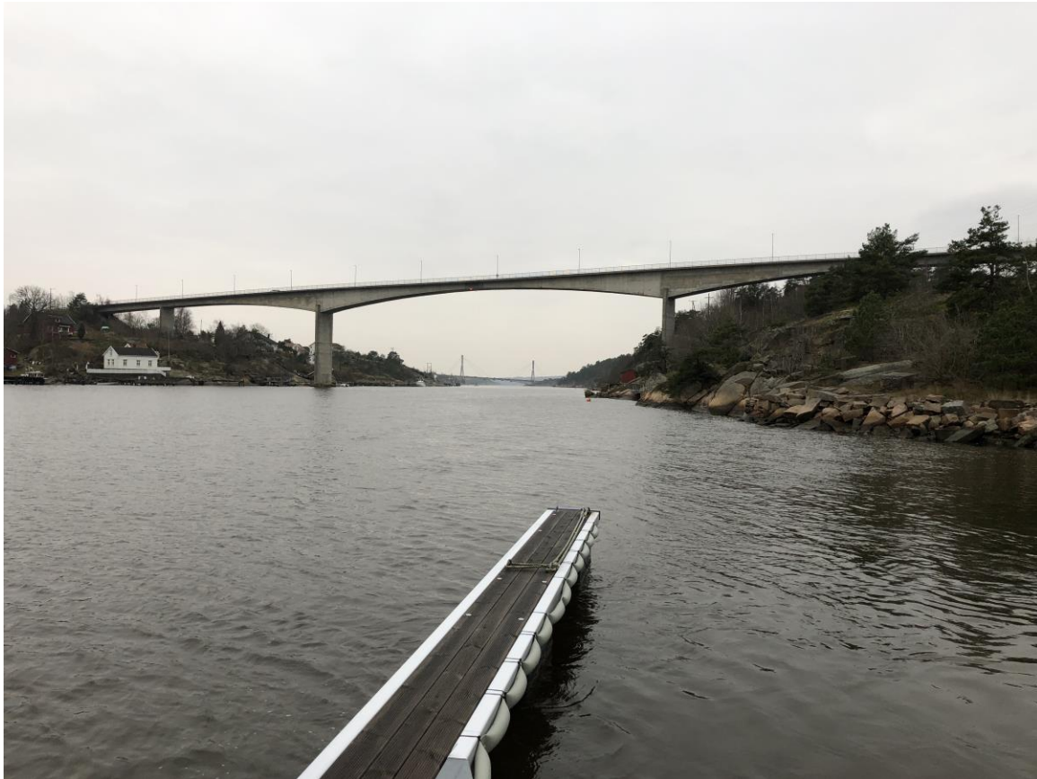
Figur 8-17 Bildet viser eksisterende bru, sett fra Sandbukta (Foto: Sweco Norge AS)
