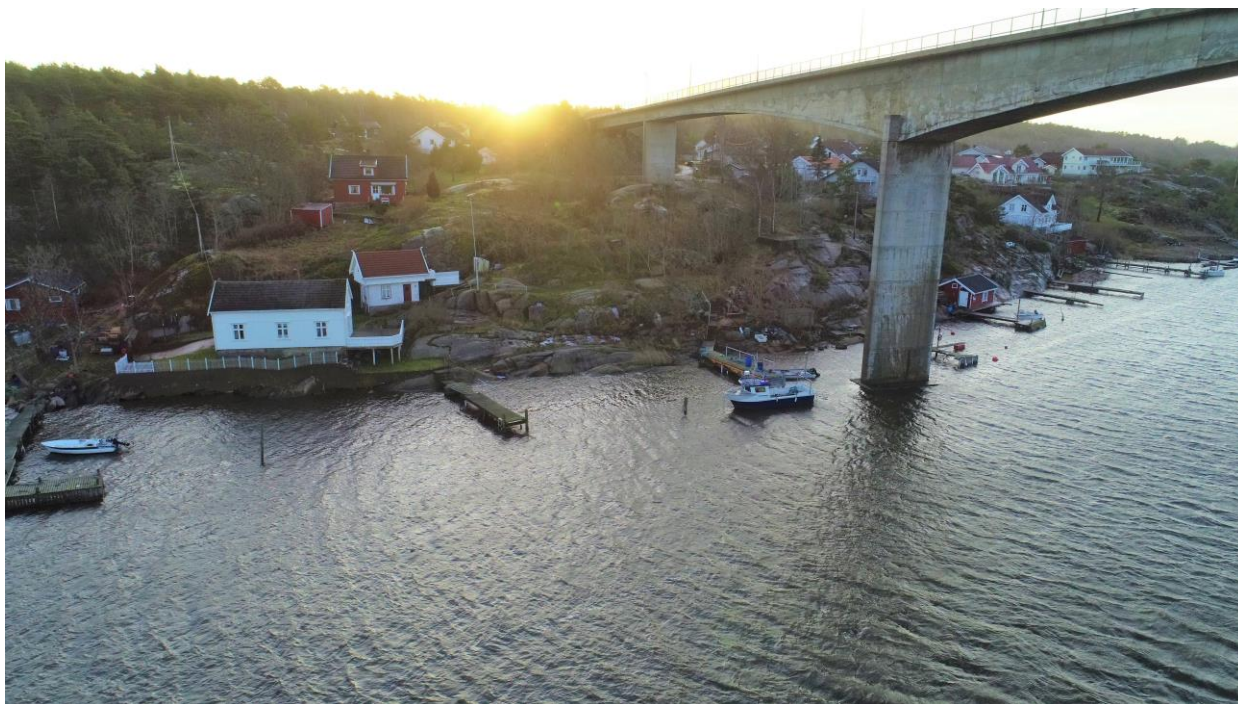
Figur 8-34 Rekvin Nordre sett fra nord for dagens bru. (foto: Sweco Norge AS)
