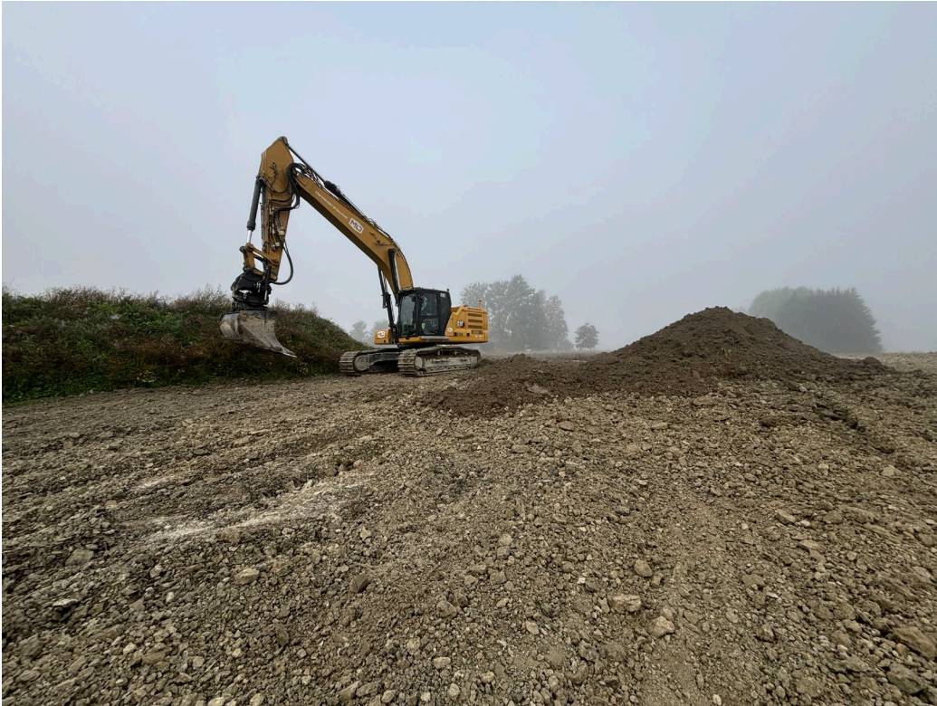
Figur 9 Bildet viser jordløsning av B-sjiktet og tilbakelegging av A-sjikt på NRVA PV2 E2 Løkenflaen. (Foto: Monica Jayesingha).
